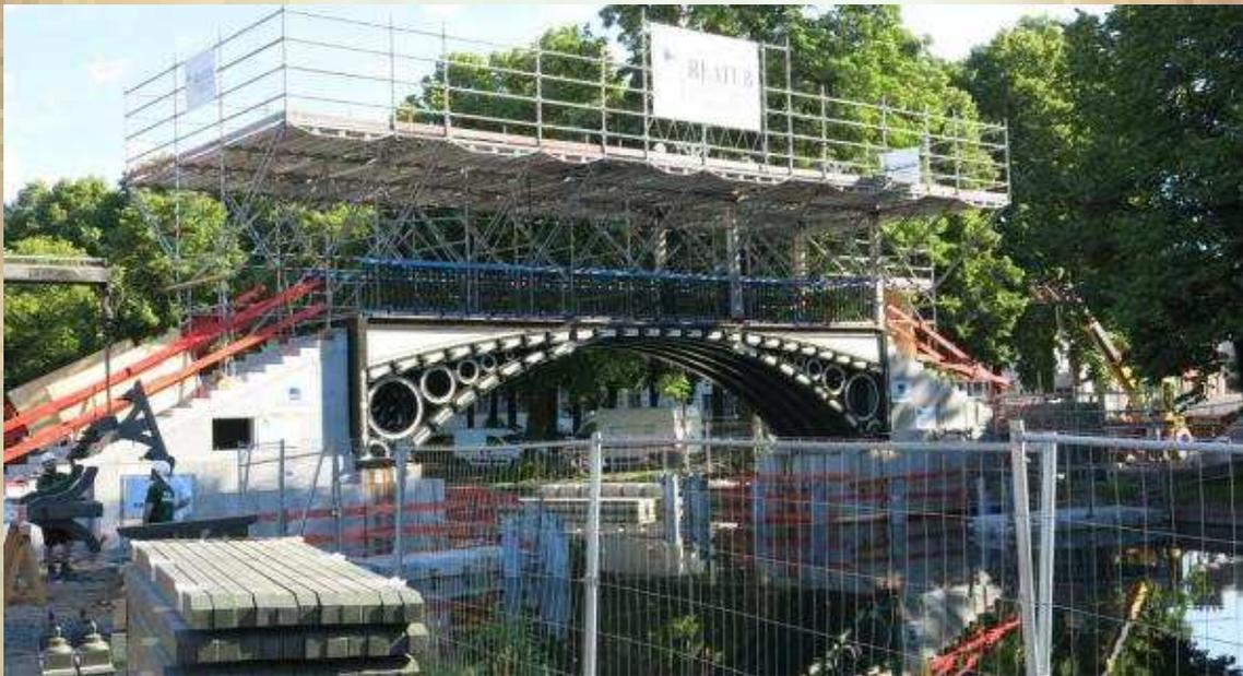
**Le chantier progresse avec la pose hier de la charpente en bois
